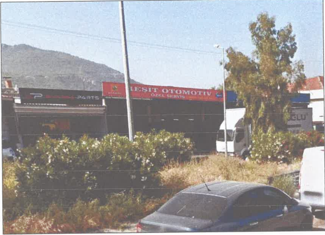
-13154/4 Güneybatısında Trafo Alanın Görşeli-
