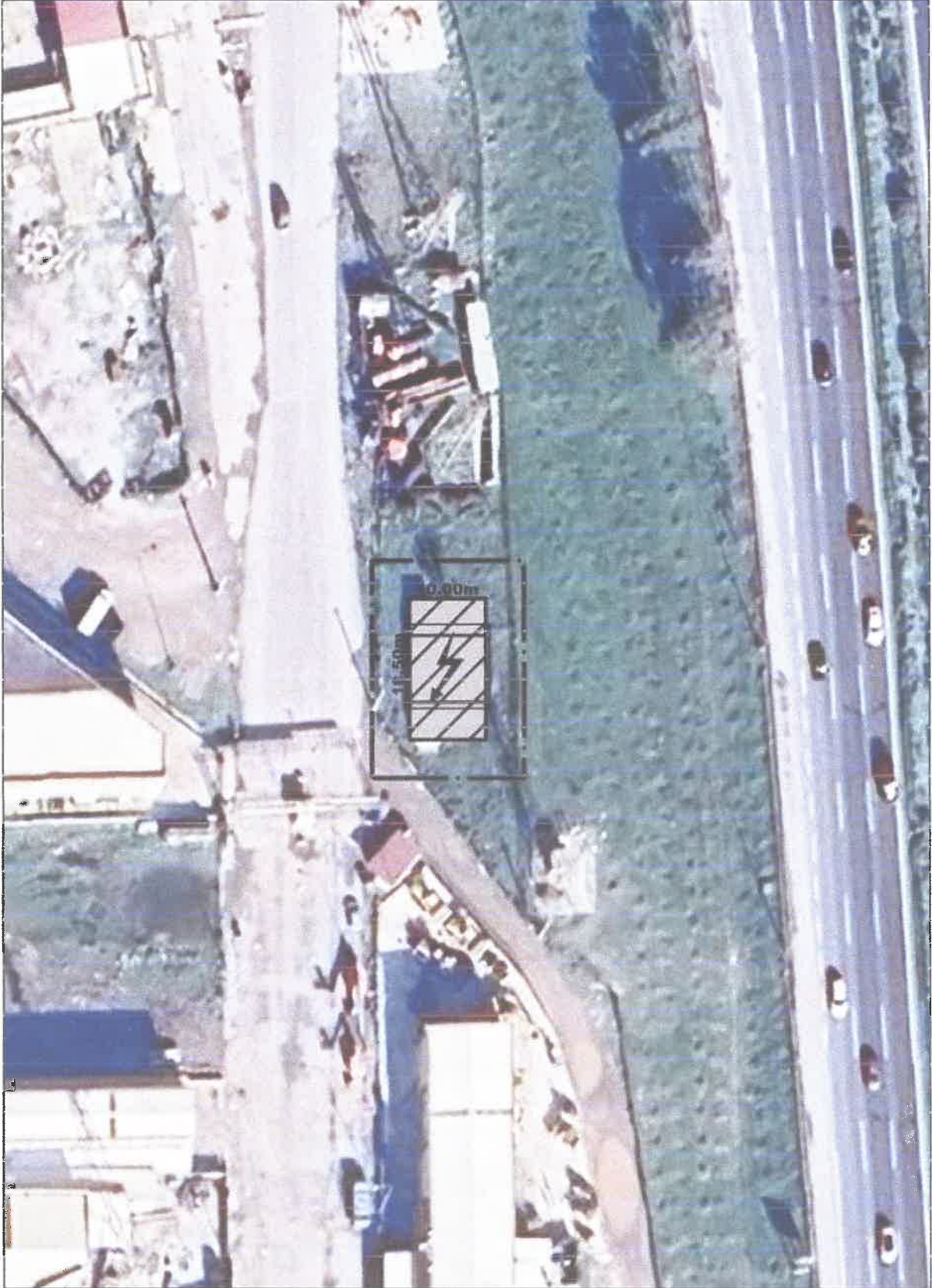
-Trafo Alanının Uydu Görüntüsündeki Konumu-
