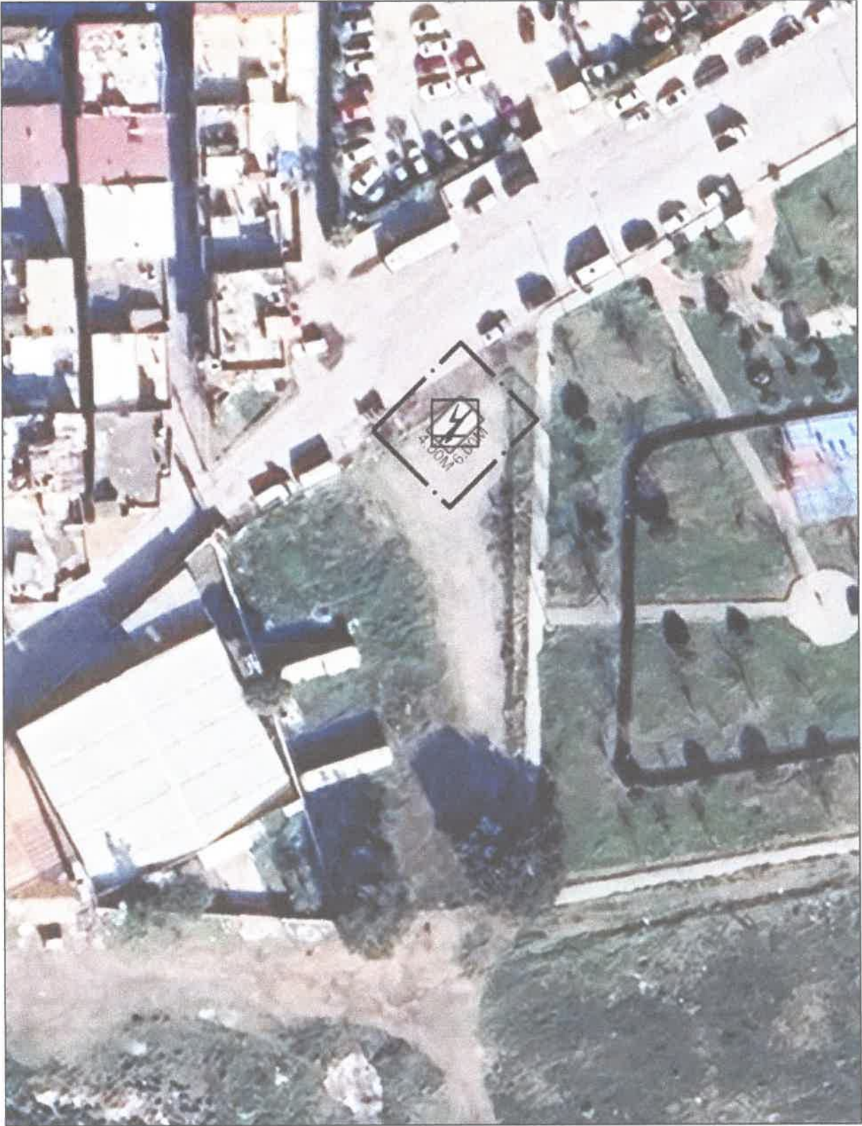
-Trafo Alanının Uydu Görüntüsündeki Konumu-
